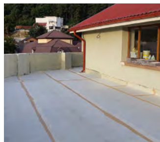
Impermeabilización de terrazas con DRY80 . Rumanía.
