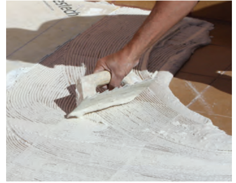
3. A continuación aplicar cemento cola clase C2 S1/S2 con lana dentada de 6/8 mm. Aplicar el adhesivo en pequeños paños para evitar que se seque y siempre peinando en un único sentido. En ningún caso instalar la lámina sobre un cemento cola semi fraguado. NOTA: en rehabilitación, aplicamos el cemento cola clase C2 S1/S2, directamente sobre el pavimento antiguo.
