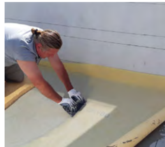
Impermeabilización de terrazas con DRY80 . Hotel H10 ATLANTIC SUNSET**** _ Playa Paraíso_Tenerife (Las Palmas).
