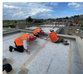
Impermeabilización de cubiertas planas transitables con ECODRY120 . RESIDENCIAL VIVIENDAS UNIFAMILIARES. Montevideo. Uruguay.
