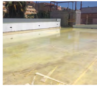
Impermeabilización de terrazas con DRY80 . Hotel H10 ATLANTIC SUNSET**** _ Playa Paraíso_Tenerife (Las Palmas).
