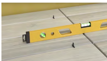
INSTALACIÓN DEL SUELO DEL BAÑO
