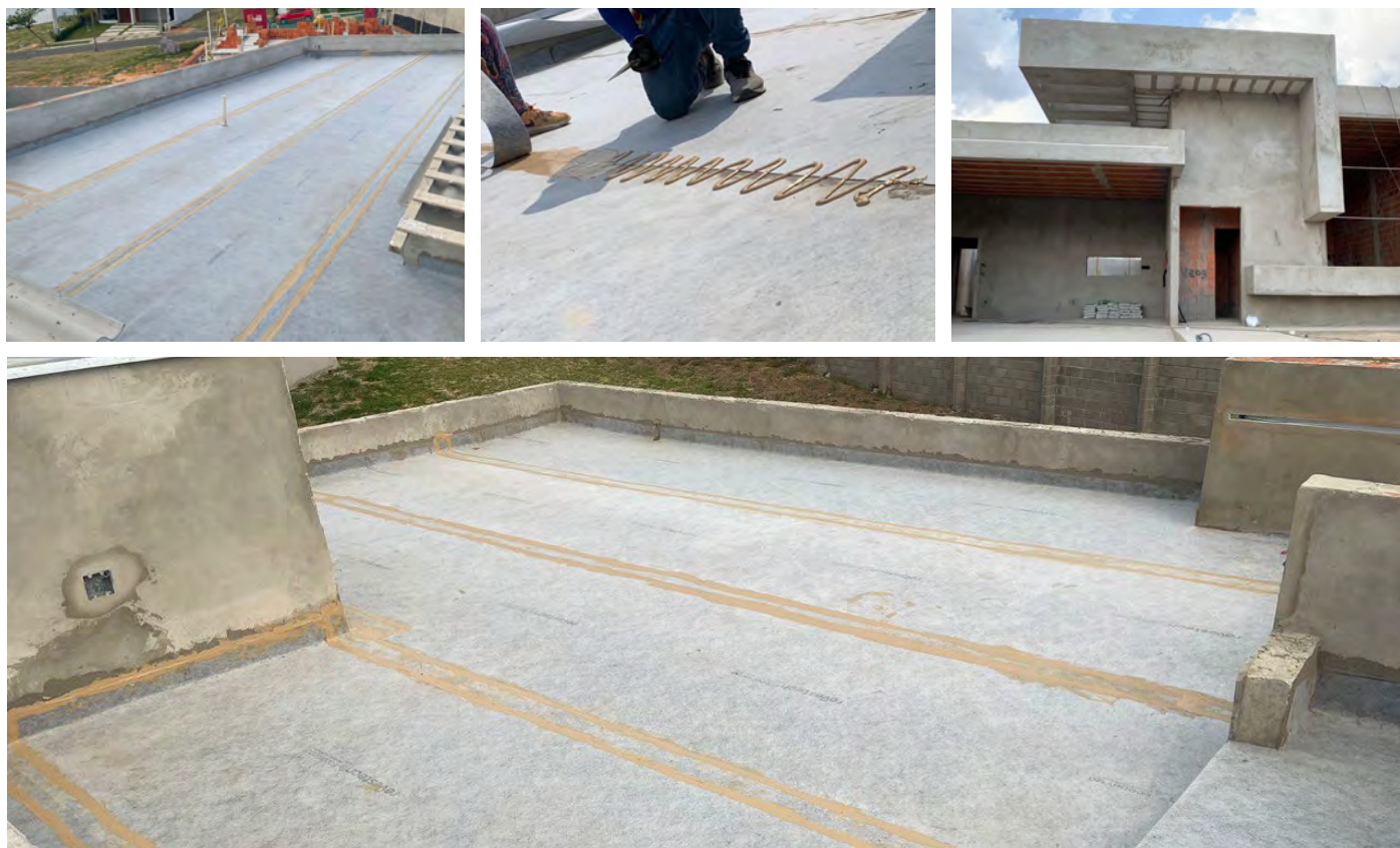
Impermeabilización de 2500 m 2 con ECODRY120 en villas de lujo. Estado de São Paulo.
