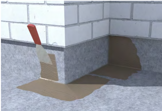
1. Una vez instalada la lámina ECODRY50/80/120 aplicar adhesivo SEALPLUS sobre la zona de rincón.
