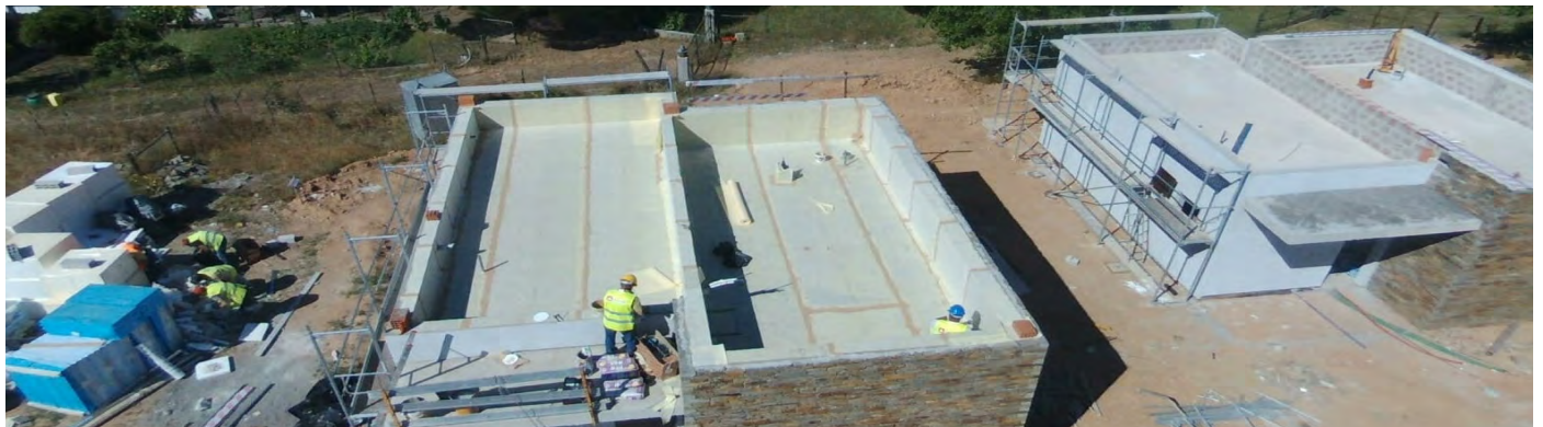
Impermeabilización de las cubiertas con DRY80 . RESIDENCIA DE 3ª EDAD EN LENSTISCAIS. Castelo Branco. Portugal.
