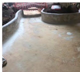
Impermeabilización de terrazas con DRY80 . Hotel MELIÁ SALINAS***** _ Lanzarote (Las Palmas).
