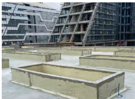
Impermeabilización de 35.000 m 2 de DRY120 en todas sus terrazas transitables exteriores. CENTRO COMERCIAL PENINSULA. Tijuana. Mexico.
