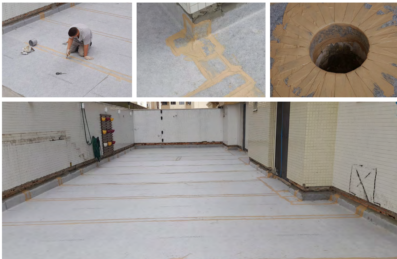
Impermeabilización de 700 m 2 con ECODRY120 en todas sus terrazas transitables exteriores. Condominio en Itapema. Brasil.
