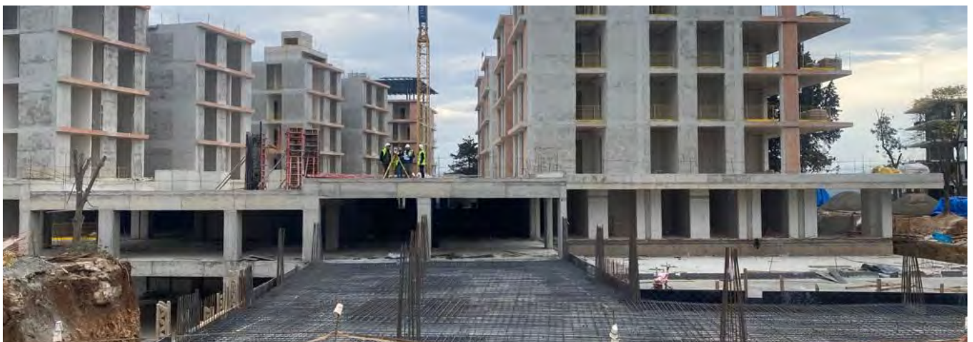
RESIDENCIAL VESEN. 55.000 m 2 DRY40 y DRY50 en interiores. DRY80 en cubiertas, terrazas y zonas comunes exteriores. Estambul. Turquía.
