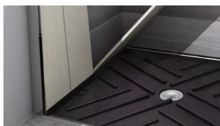
VERIFICACIÓN DE LA INSTALACIÓN
