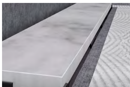
18. Colocar la pieza de cerámica sobre el LINEAL/SUMI LEVEL .
