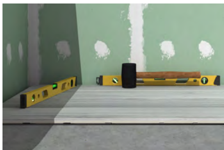
INSTALACIÓN DEL PLATO
