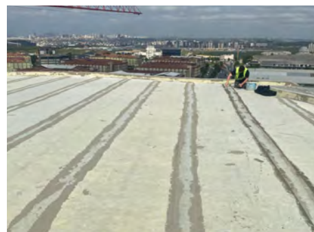
Impermeabilización de 35.000 m 2 de DRY120 en todas sus terrazas transitables exteriores. CENTRO COMERCIAL PENINSULA. Tijuana. Mexico.
