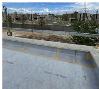
Impermeabilización de cubiertas planas transitables con ECODRY120 . RESIDENCIAL VIVIENDAS UNIFAMILIARES. Montevideo. Uruguay.
