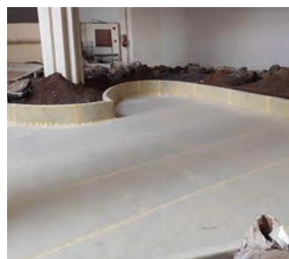
Impermeabilización de los jardines interiores con DRY80 diseñados por César Manrique. Hotel MELIÀ SALINAS Costa Teguise. Tenerife.
