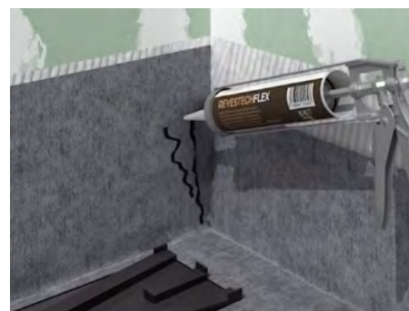
13. Formar las esquinas plegando la lámina. Aplicar REVESTTECHFLEX para pegar el pliegue.
