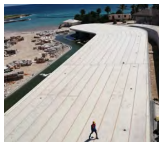
Impermeabilización de 8.000 m 2 de cubiertas planas transitables con DRY80 . Hotel SAINT REGIS Punta Cana. R. Dominicana.
