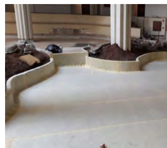
Impermeabilización de los jardines interiores con DRY80 diseñados por César Manrique. Hotel MELIÀ SALINAS Costa Teguise. Tenerife.
