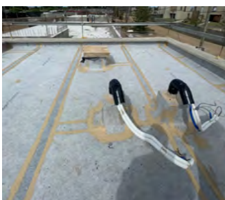
Impermeabilización de cubiertas planas transitables con ECODRY120 . RESIDENCIAL VIVIENDAS UNIFAMILIARES. Montevideo. Uruguay.
