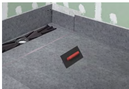
15. Comprobar que la lámina esté bien extendida y sacar el aire que se pueda haber generado con ayuda de la llana.
