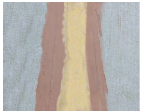
6. Sellar la banda DRYBANDA 13 con otra pasada de adhesivo SEALPLUS (doble sellado).
