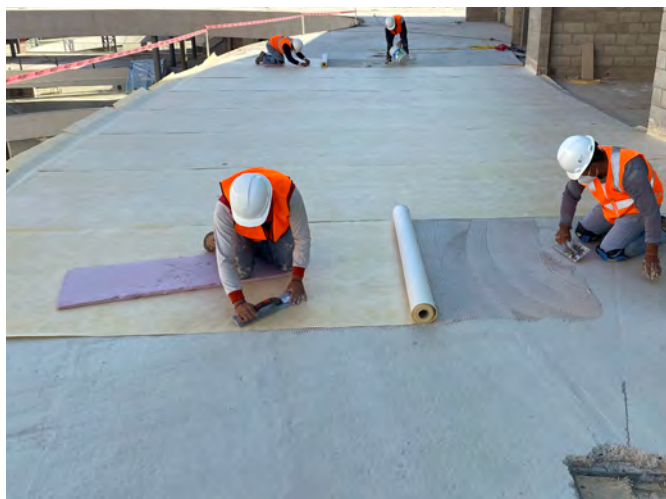
Impermeabilización de 35.000 m 2 de DRY120 en todas sus terrazas transitables exteriores. CENTRO COMERCIAL PENINSULA. Tijuana. Mexico.
