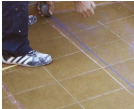
2. Replanteo, medición y corte de los paños.
