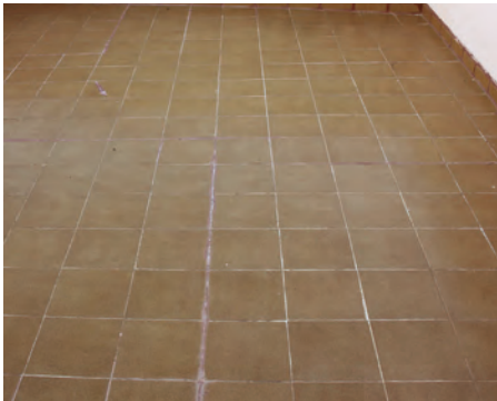
1. Comprobar la estabilidad del soporte y limpiar la superficie. Es conveniente utilizar sosa cáustica para una limpieza más eficaz.
