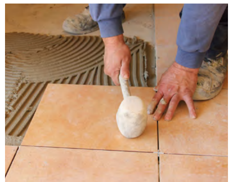
9. Colocar el pavimento directamente con cemento cola C2 y fijar el rodapié.
